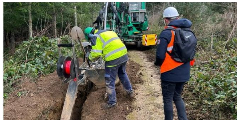
Enedis a mené un chantier d'enfouissement visant à améliorer la résilience d'un tronçon de 12 km de lignes aériennes moyenne tension alimentant 3 800 clients. (Crédits : DR, Enedis)
