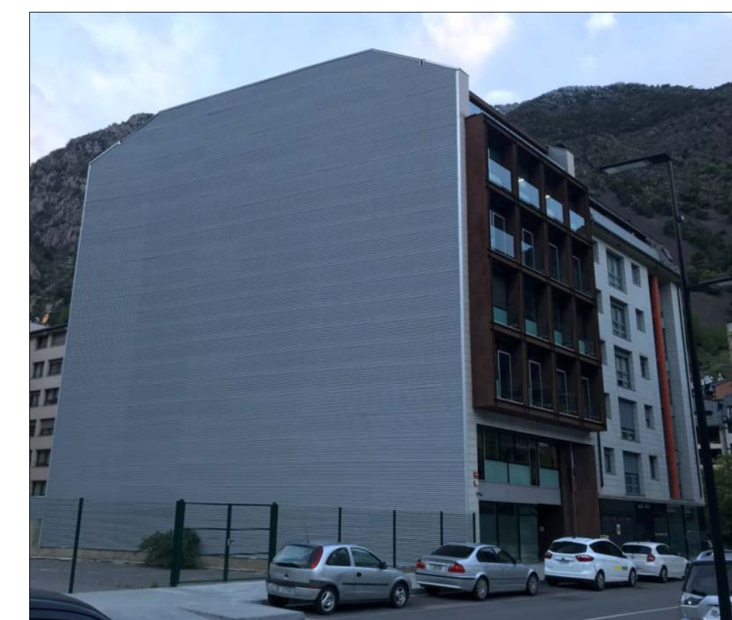
Photos 3 et 4. Lors du projet POCRISC, le bâtiment Prat del Rull d'Andorre sera instrumentalisé pour en étudier son comportement, au moyen d'accéléromètres (photo 3) et de mesures RAR (Real Aperture Radar). Ce bâtiment essentiel héberge le Département de Protection Civile et le Centre National Routier d'Andorre.
